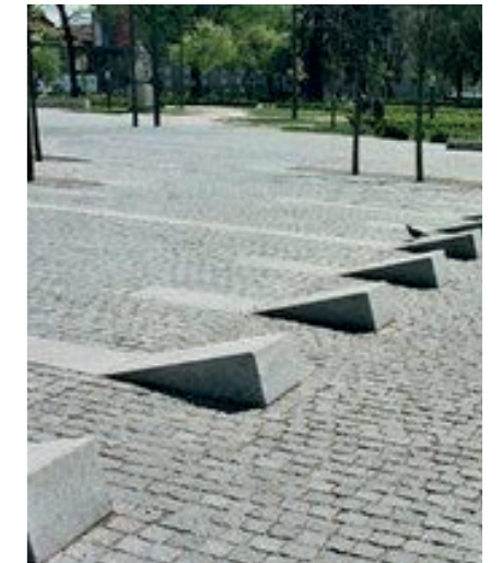
Påkörningsskydd i betong eller stenmaterial separerar flöden och skapar säkra passager för gående.
