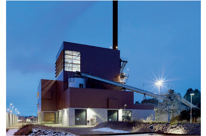
Inglasningar i fasad visar del av anläggningens tekniska installationer. Kraftvärmeverk Oskarshamn, Liljewall Arkitekter
