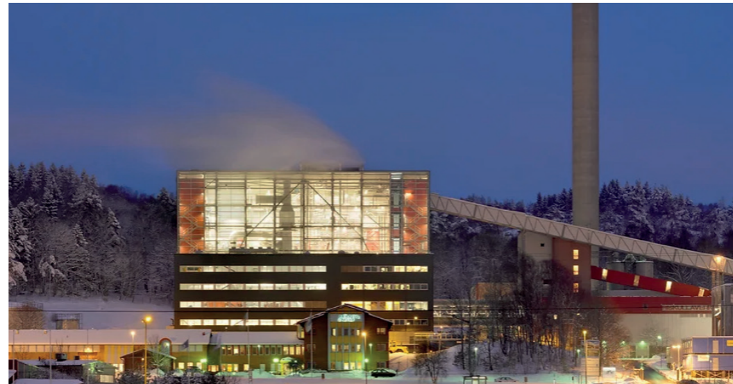
Stora inglasningar i fasaden bidrar till trygghet i området och skapar ett landmärke i stadsrummet. Kraftvärmeverk Riskulla, Mölndal energi, Liljewall Arkitekter
