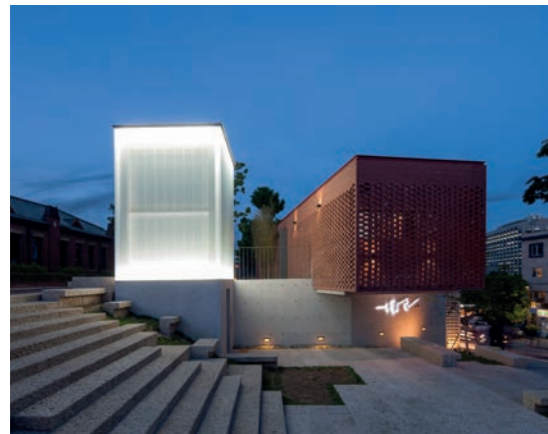
Fasad i kanalplast kompletteras med belysning för att skapa en markör i landskapet. Interkerd architects
