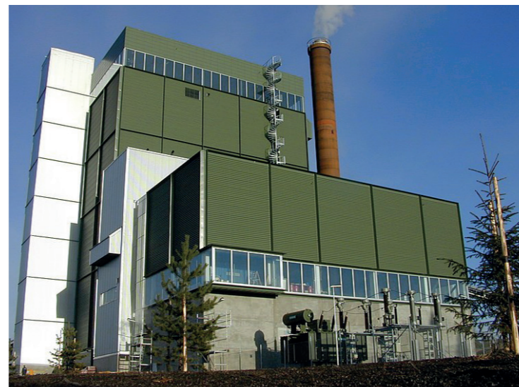
Material och färgskala skapar en helhet. Jämtkraft Värmeverk, Foster Wheeler
