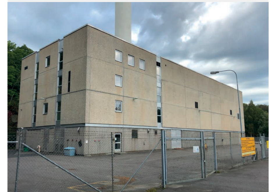
Foto: Panncentralen Angered
